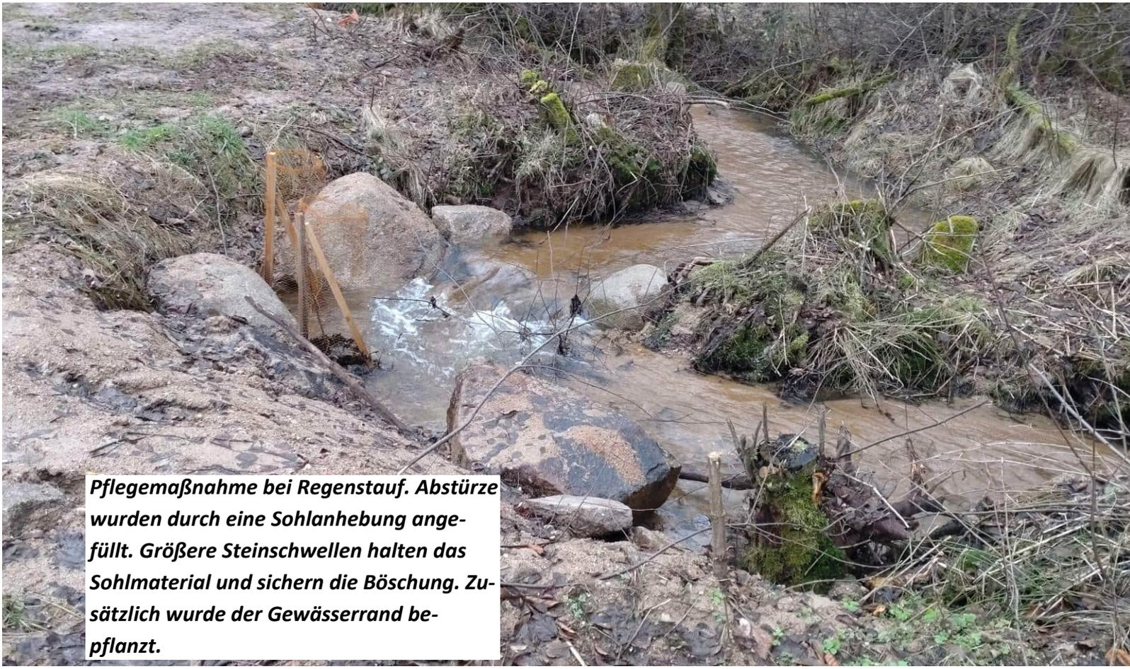
***Pflegemaßnahme bei Regenstauf. Abstürze wurden durch eine Sohlanhebung angefüllt. Größere Steinschwellen halten das Sohlmaterial und sichern die Böschung. Zusätzlich wurde der Gewässerrand bepflanzt.***
